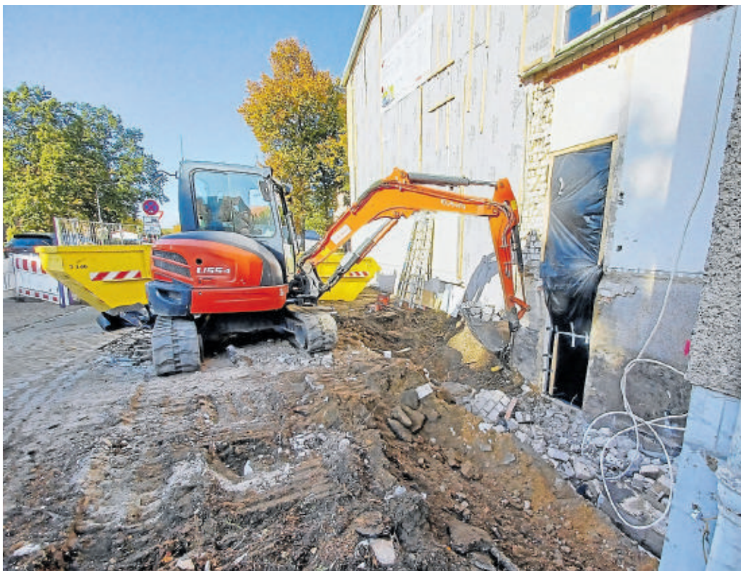
Eine abgesperrte Baustelle gehört zur großen Sanierung der Sportstätte.
