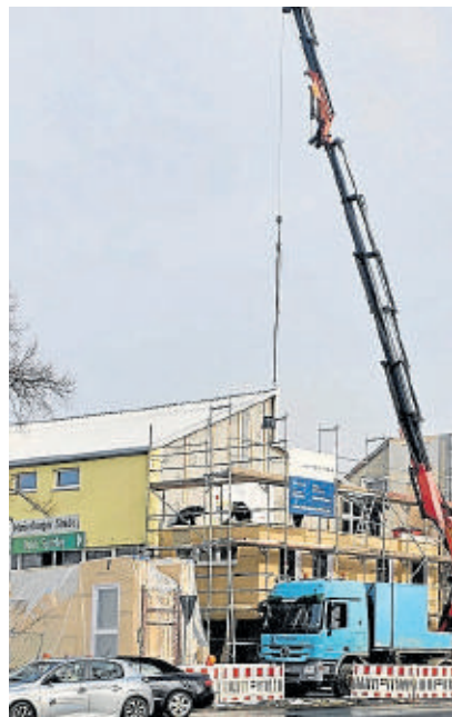
Ein Kran hievt bereits in der vorigen Woche die Holzelemente an ihren Platz. Foto: Epping
